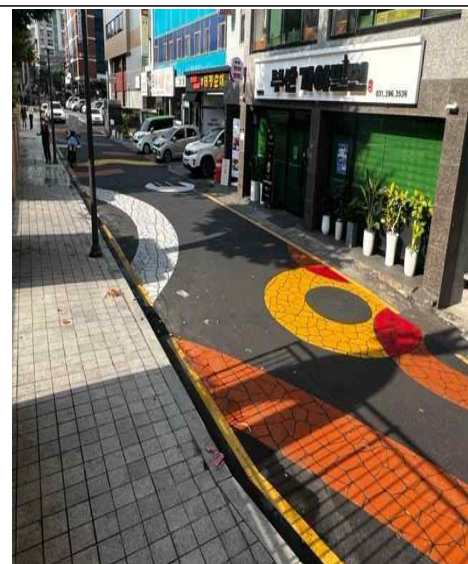
바닥 스텐실 포장 (후)
