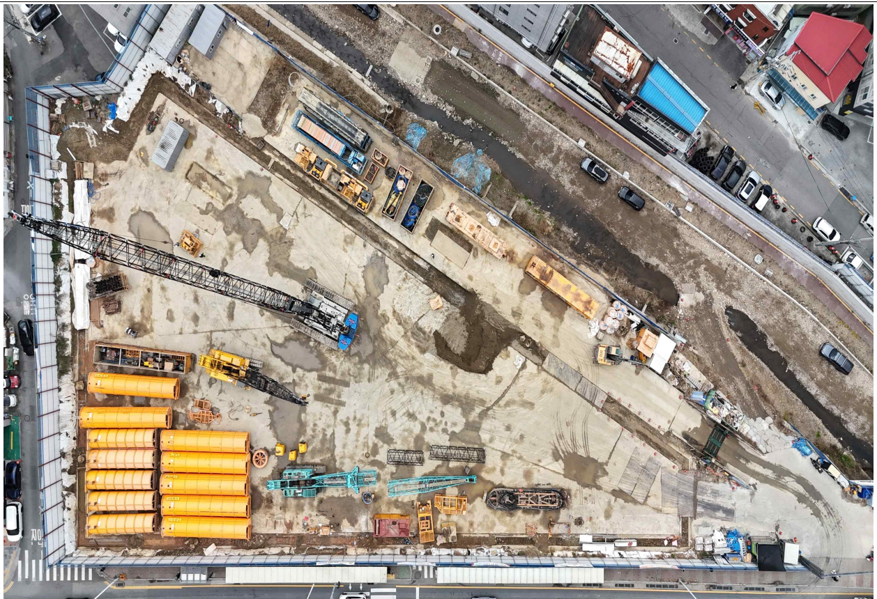
최근 공사 사진
